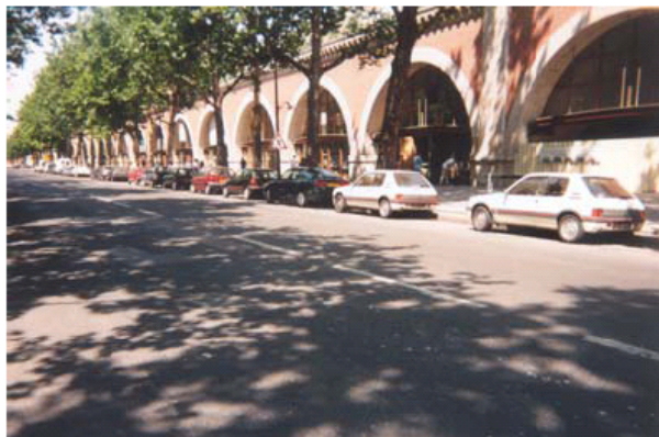
LE VIADUC DES ARTS
